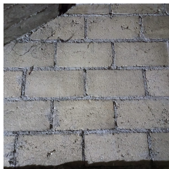
Figura 2.70: Mosaico en una pared en construcción.
